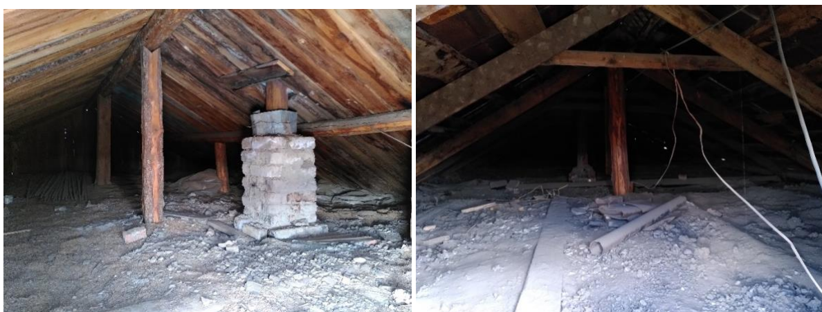
Муухан дээвэртэй байшингийн жишээ: Зүүн талд сүвлэгээтэй шувуу нуруутай байшингийн дээвэр Баруун талд дан шувуу нуруутай байшингийн дээвэр
