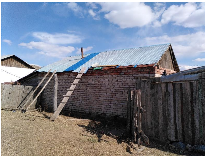
Битүүмжлэл муутай дээврийн жишээ (яндангийн чигжээс хийгээгүй дээврийн төмөр нь эвдэрч хуучирсан).
